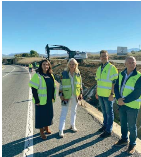
Colombo y Sánchez visitan las obras en la A-384. JUNTA DE ANDALUCÍA
